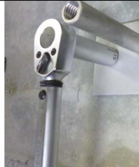
5) Alle vier Fischer Hohldeckenanker FHY 10 mit dem Hammer einschlagen, bis diese eben mit der Betonfläche anliegen.
