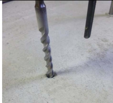
1) Zur Markierung der vier Bohrlöcher die Grundplatte mit einem Randabstand zur Betonkante von 300 mm (nicht zur Gebäudekante) auf die Betonplatte stellen und die Bohrlöcher anzeichnen
